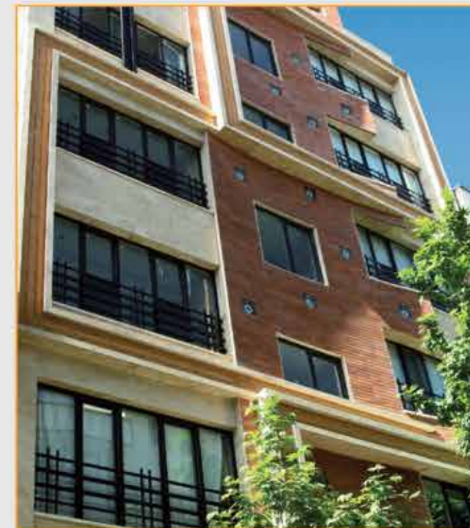
آجر بکار رفته کد : N5(A3) Code of Used brick:
